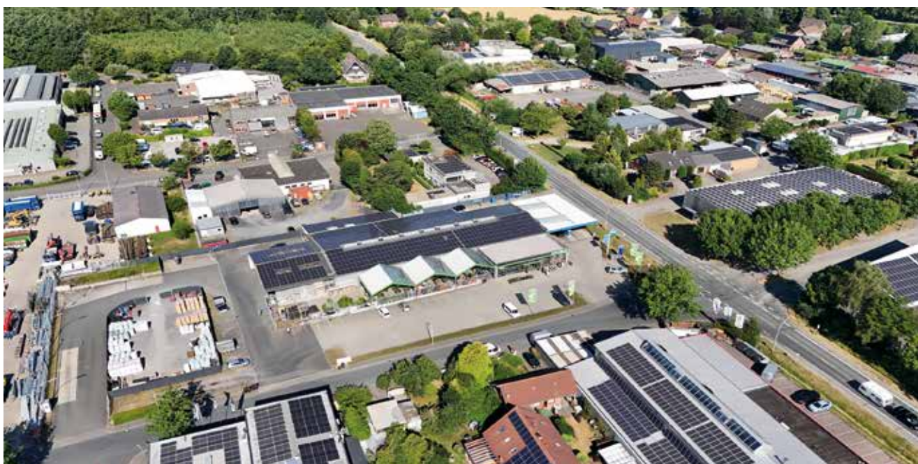
Blick auf die Industriestraße, Gewerbegebiet Senden Süd, aus westlicher Richtung
