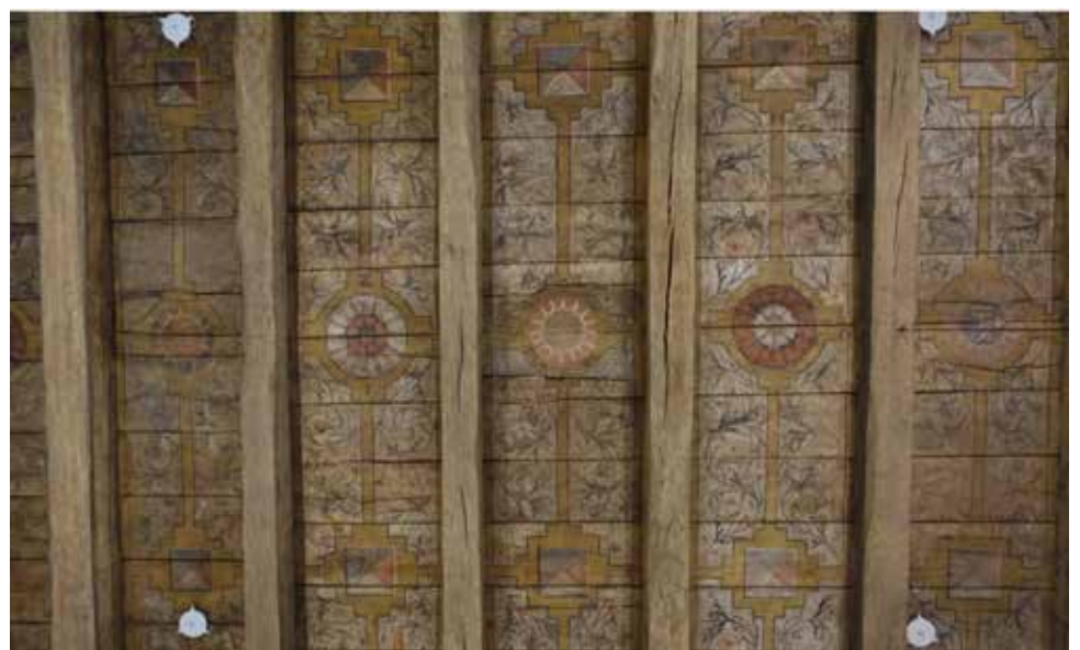
Blick in die Renaissance-Holzbalkendecke Kapelle Venne
